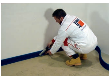
1. Montarea benzilor de etanșare
